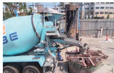
杭コンクリート打設
