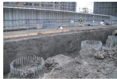
改良土 山留め工法 (施工完了)
