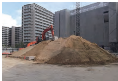
敷地内の土砂仮置き
