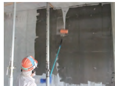
ひび割れ防止工法
