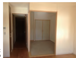
施工した和室プレカット枠
