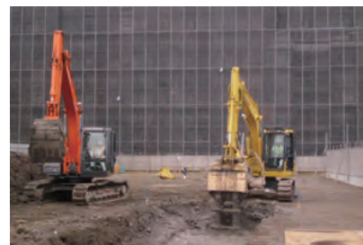
改良土 山留め工法 (施工中)
