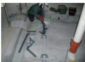
排水プレカット施工のようす
