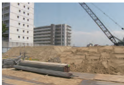
敷地内の土砂仮置き
